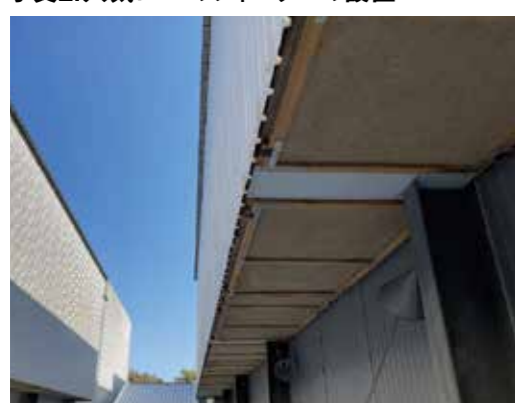
写真2. 入気口へのフィルターの設置
