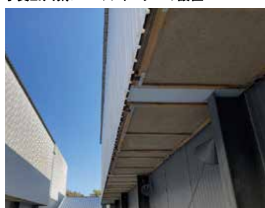
写真2. 入気口へのフィルターの設置
