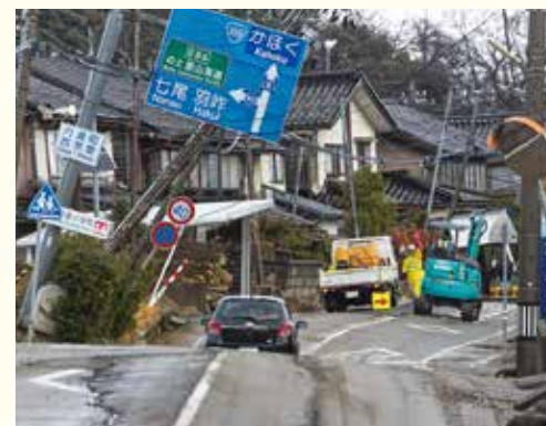
内灘町で液状化被害が発生した地域(24年1月7日撮影)
